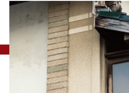
当時の外観を構成したと考えられるスクラッチタイル
