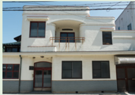
近隣の看板建築との比較
