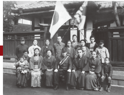
竣工後の旧矢崎商店の様子
